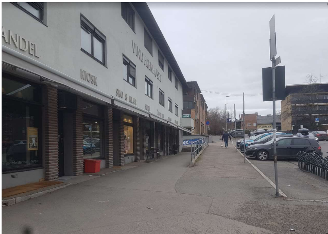
Figur 1: Bilde av den aktuelle muren.
